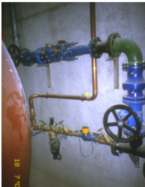
Abb. 49: Hauptwasserzähler mit Impulszählerausgang im sog. Hydrantenraum im Keller. Im rechten Bild sieht man den installierten Impulszähler und M-Bus-Umsetzer (schwarzer Kasten oben).
