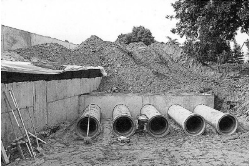
Abb. 107: Erdreichwärmeübertrager im Bau. Erste Rohrabschnitte am Ansaugbauwerk (Foto M. Zimmer)
