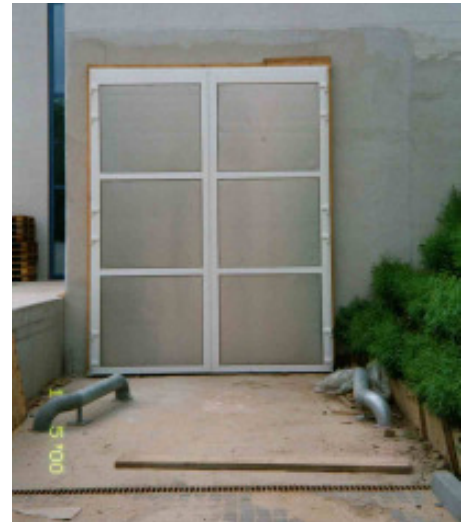
Abb. 3: Links : Nordfassade des Gebäudes mit dem abgesenkten Ladebereich mit der Laderampe und dem LKW-Tor. Rechts : Geschlossenes LKW-Tor aus Vakuum-Paneelen im Lagertrakt des Gebäudes. Später wurde das Tor gegen ein Rolltor aus PU-Dämmpaneelen ausgewechselt.
