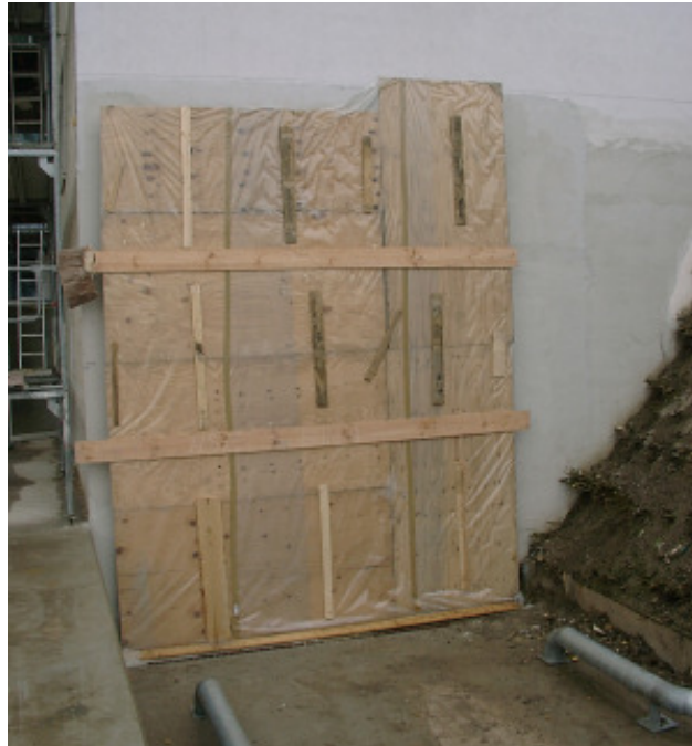
Abb. 14: Provisorisch luftdichte Abklebung des LKW-Ladetors an der Nordfassade des Lagertraktes
