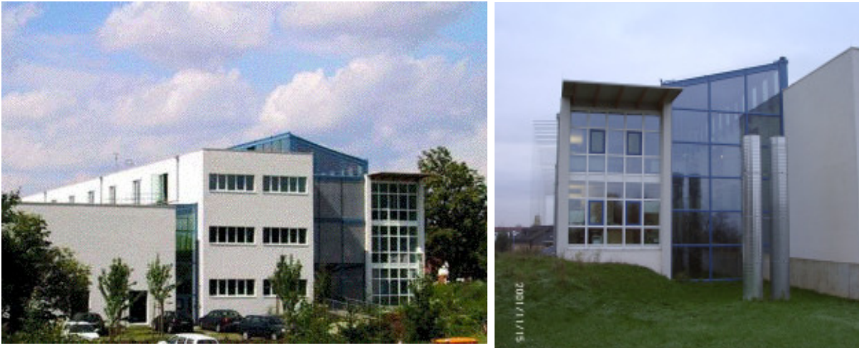
Abb. 1: Links: Südfassade mit den Bereichen Lager, Produktion/Labor, Atrium und Büro (von links nach rechts). Rechts: Nordfassade von Büro- und Atriumbereich. Im Vordergrund sind die beiden Fortluftrohre zu sehen.
