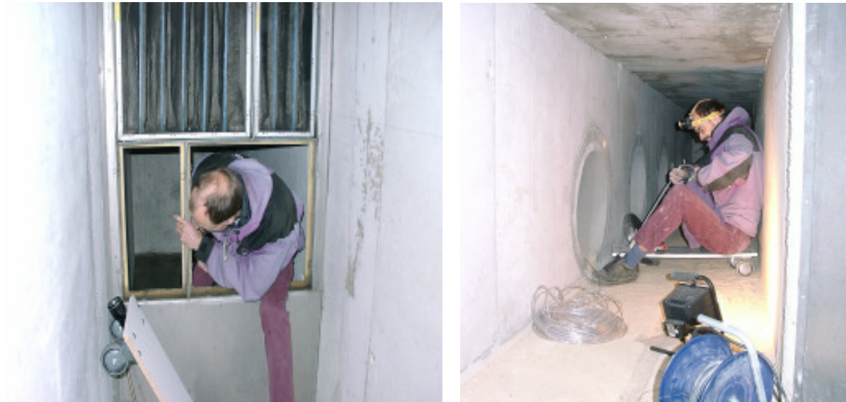
Abb. 55: Montage der Druckaufnehmer im Erdreichwärmetauscher (ERWT). Links: Zugang zum Verteilerschacht am Ansaugbauwerk des ERWT durch die Demontage von zwei Außenluftfiltern. Rechts: Vorbereitungen im Sammelschacht des ERWT auf der Seite des Technikellers. Mit einem speziellen Rollbrett werden die Röhren einzeln durchfahren, die Rohrlänge gemessen, die Druckaufnehmer montiert und die Schläuche verlegt.
