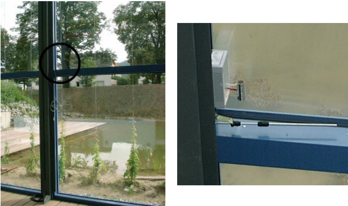
Abb. 60: Ost-Verglasung der Cafeteria mit der Position des Luftströmungsgeschwindigkeits-Sensors (Kreis). Der Sensor wurde ca. 8 cm über dem Riegel montiert (dünne „Stange“). Am Pfosten ist zusätzlich eine Strahlungsgeschützte Lufttemperaturmessstelle montiert.
