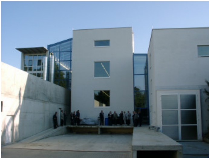
Abb. 3: Links : Nordfassade des Gebäudes mit dem abgesenkten Ladebereich mit der Laderampe und dem LKW-Tor. Rechts : Geschlossenes LKW-Tor aus Vakuum-Paneelen im Lagertrakt des Gebäudes. Später wurde das Tor gegen ein Rolltor aus PU-Dämmpaneelen ausgewechselt.
