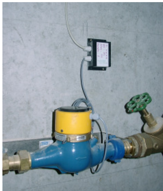
Abb. 49: Hauptwasserzähler mit Impulszählerausgang im sog. Hydrantenraum im Keller. Im rechten Bild sieht man den installierten Impulszähler und M-Bus-Umsetzer (schwarzer Kasten oben).
