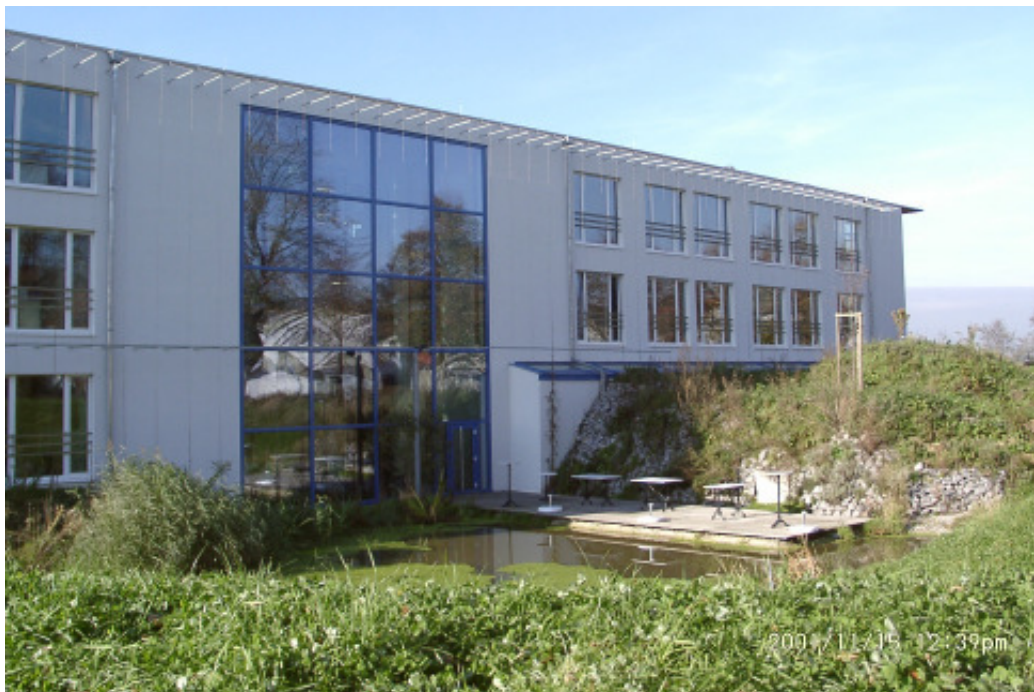
Abb. 2: Links: Ostfassade des Gebäudes mit den Bürobereichen. Vor der Fassade sind Rankhilfen für Kletterpflanzen gespannt. Diese sollen, wenn sie ausgewachsen sind, den Sonnenschutz darstellen. Der vollverglaste Teil stellt den Cafeteria-Bereich dar. Von diesem gelangt man auf die Außenterrasse am Teich.
