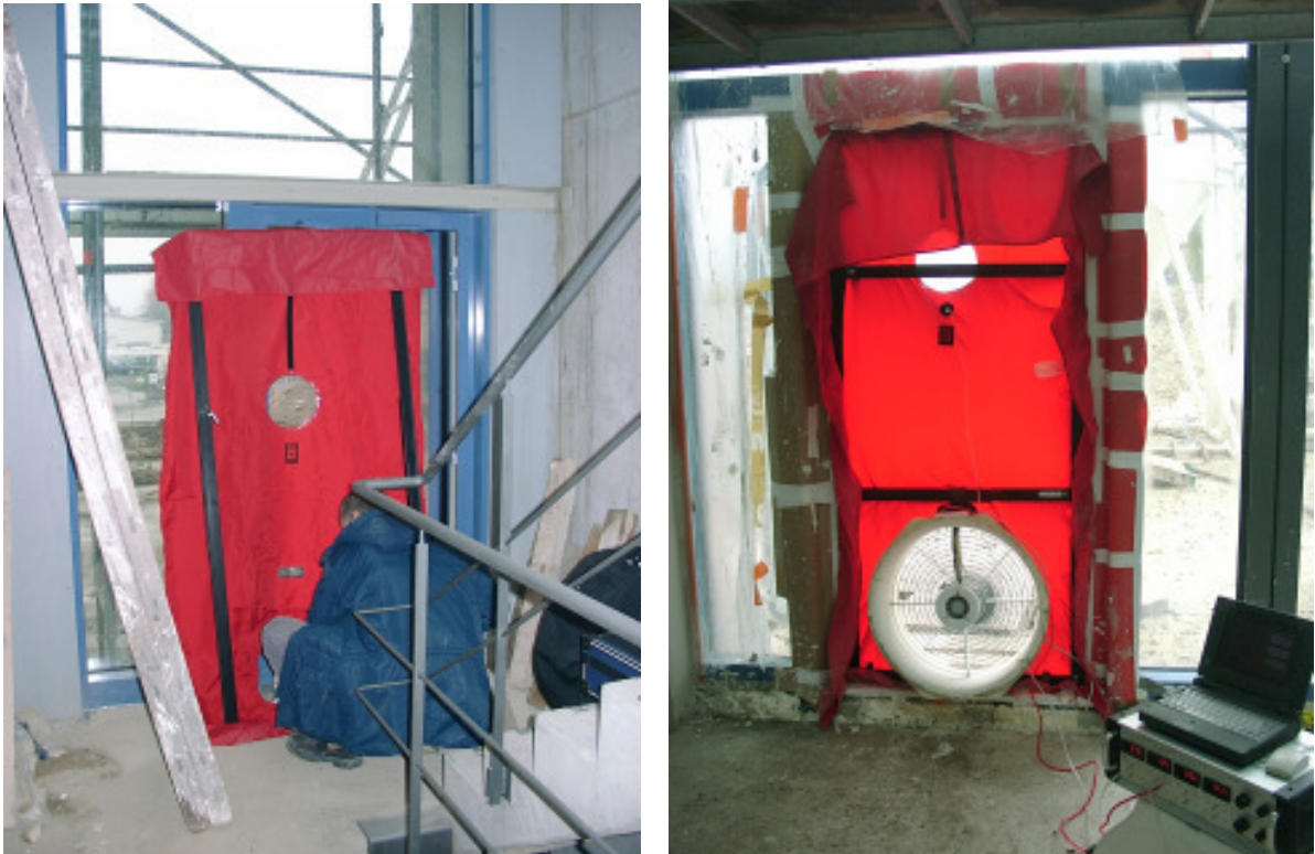
Abb. 15: Links: Vorbereitungen zum Einbau der ersten Blower Door in die Tür im Lichtgang (Südfassade). Rechts: Installierte zweite Blower Door in der Tür zum späteren Freigelände/Pausenbereich vor der Cafeteria (Ostfassade) während der Messung
